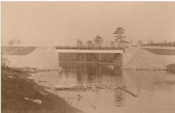
Luovenjoen silta v. 1938. Venäläiset rakensivat talvisodan aikana uuden puusillan tuhoutuneen tilalle.
