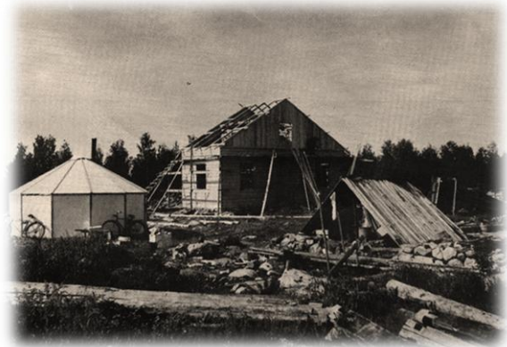
Jälleenrakennus käynnissä Miikkulanvaarassa v. 1943.
