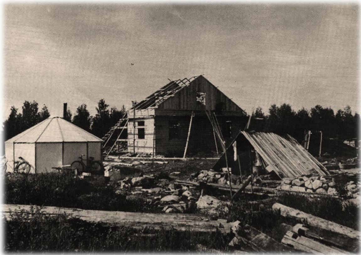
Juho Kettusen uudisrakennus Miikkulanvaarassa 1943
