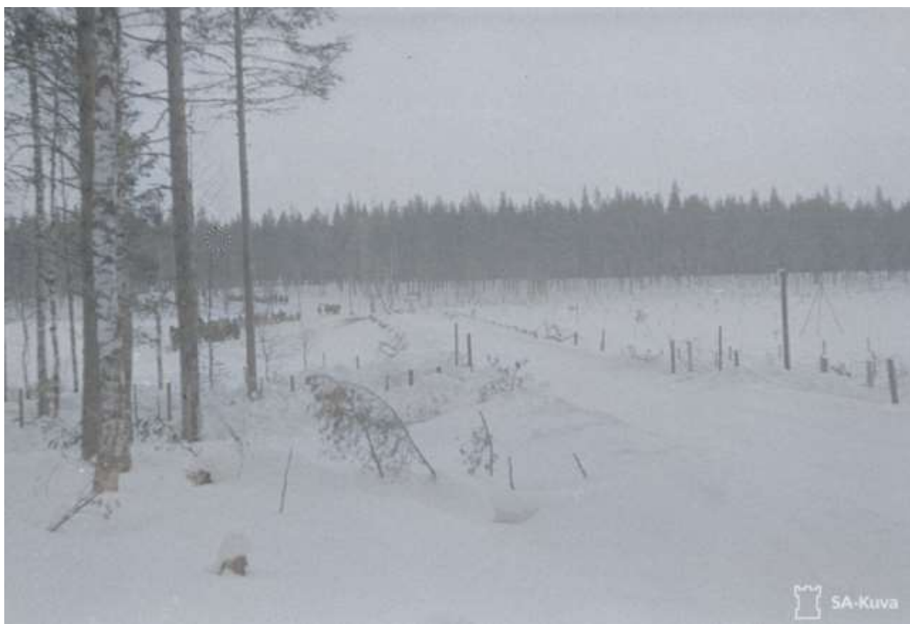
Ristisalmi maaliskuussa 1940 (SA-kuva)
