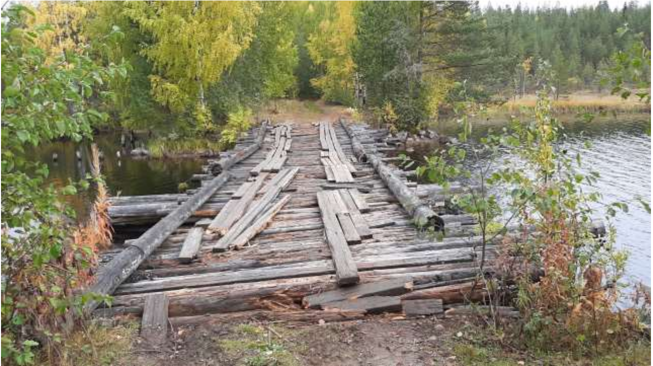
Ristisalmen siltaa syyskuussa 2019
