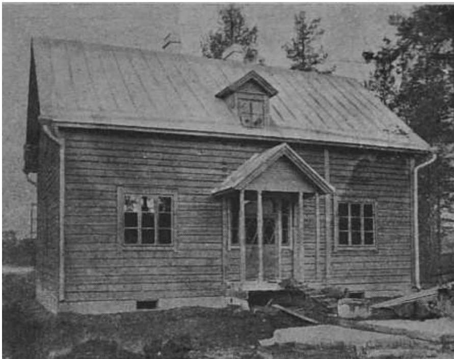
Kuolismaan Punaisen Ristin Sairasmaja rakennusvaiheessa vuonna 1926
